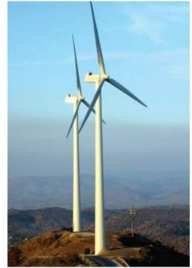
الشكل ٦ تعمل مراوح الهواء بنفس مبدأ منشآت الطاقة، وبدلاً من إدارة المحرك البخار يُدار بالمراوح التي تحركها الرياح.
