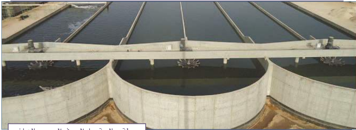
محطة معالجة مياه الصرف الصحي بالرياض
